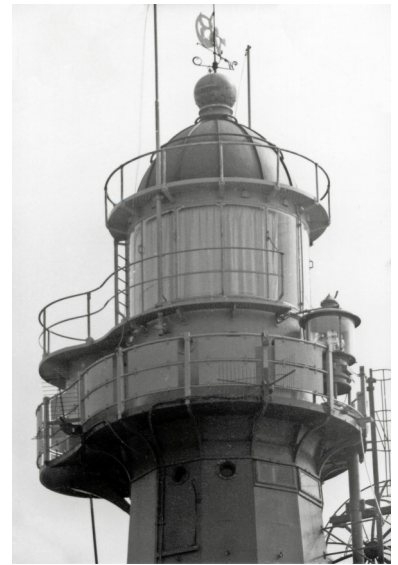
De kop van de vuurtoren in 1960. Op de omloop is een hulplicht geplaatst.
