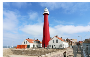
Vuurtoren en lichtwachterswoningen in april 2021. Het gebouw van het Loodswezen ernaast is geheel gesloopt. De bouw van het appartementencomplex moet nog beginnen.
