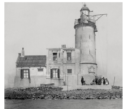
De vuurtoren begin jaren '20, met de in 1918 gerealiseerde motorkamer.
