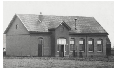
Het machinegebouw aan de Grindweg, thans Casembroodstraat, in 1907.
