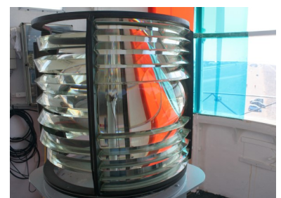
De huidige optiek, een trommellens van de vierde grootte.
