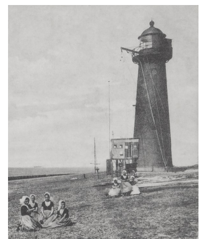
De vuurtoren in de jaren '10, met de in 1905 gebouwde houten uitkijkpost.
